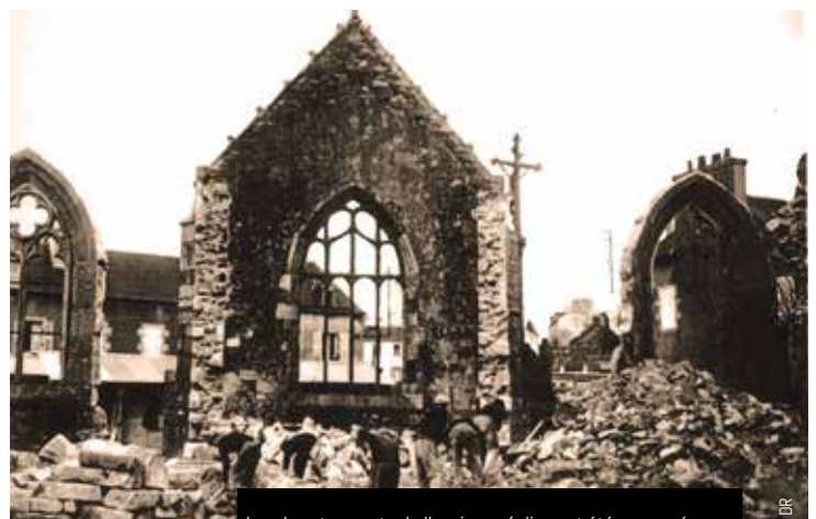
Les deux transepts de l'ancienne église ont été conservés
